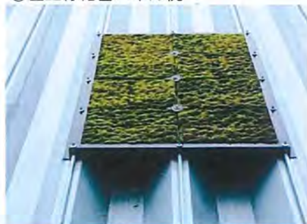
④屋上緑化苔パネル例
