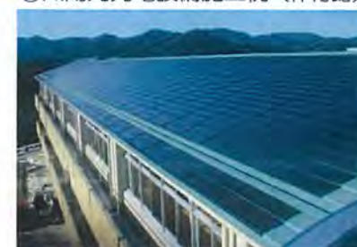
③太陽光発電設備施工例（体育館）
